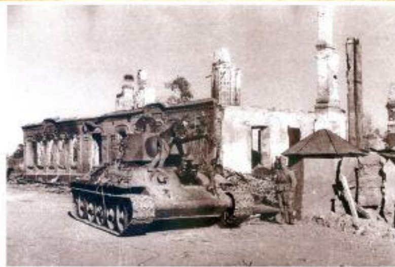
Ельня. Освобождена 30 августа 1943 г.
